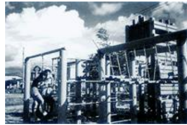
昭和63年4月 花北公園改良整備工事完了
